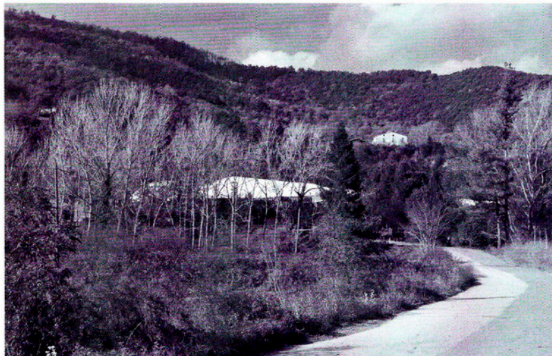
L'actual planta d'envasament de l'aigua d'Amer perfectament integrada en el paisatge.
