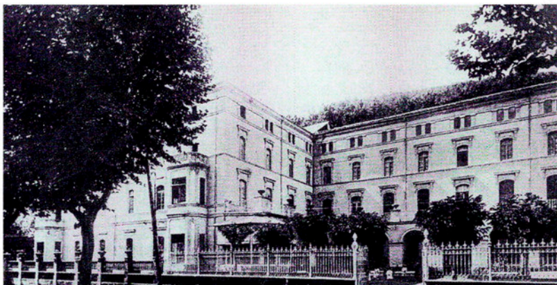
Antic establiment de banys del balneari Montagut, enderrocat un cop acabada la Guerra Civil.
